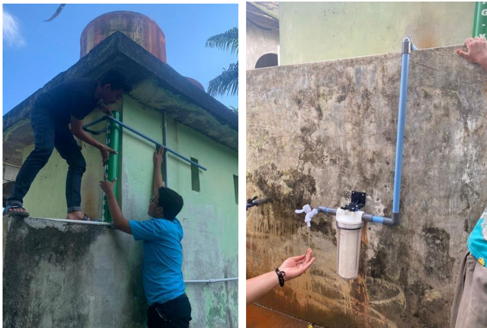
Gambar 6. Pengecatan dan pemasangan sistem penyaring air
