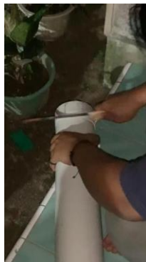
Gambar 2. Proses Pemotongan Pipa
