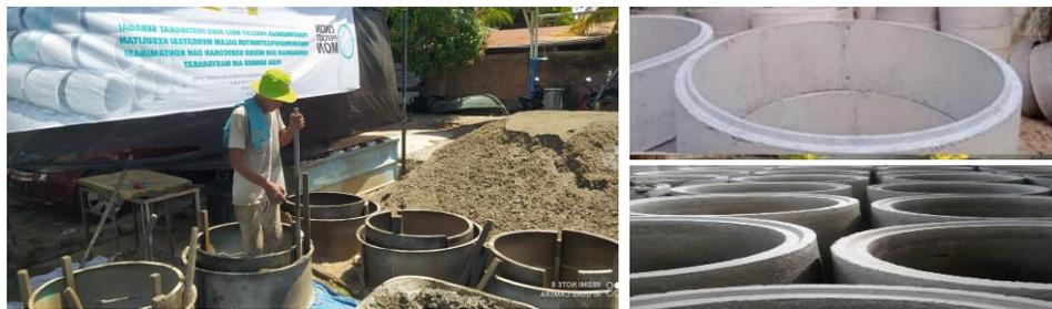
Gambar 3. Proses Tahapan Pembuatan Cincin Sumur Berbahan Beton
