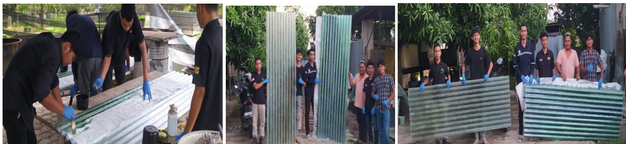
Gambar 5. Hasil akhir seng fiber berbasis komposit fiberglass dengan profil bergelombang menyerupai seng atap konvensional.
